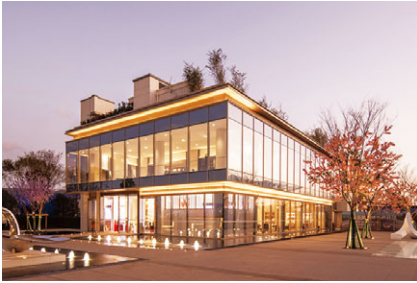
昆明經開24號項目 Kunming Jingkai No. 24 Project
