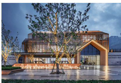
成都旭輝·天府未來中心 Chengdu CIFI - Tianfu Weilai Centre
