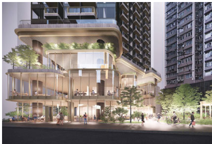
香港炮台山英皇道101號 101 King's Road Hong Kong
